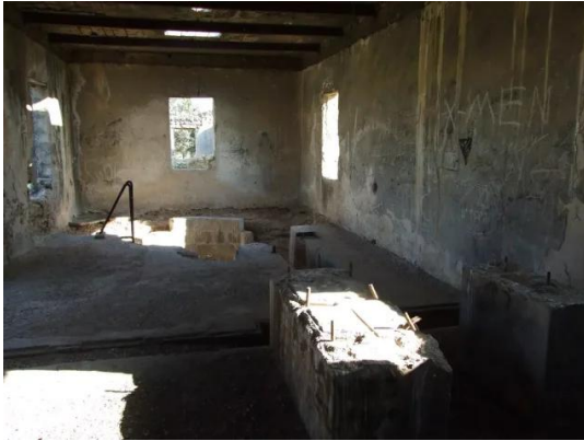
جولس: بئر عميق وفوقه مبنى كبير
