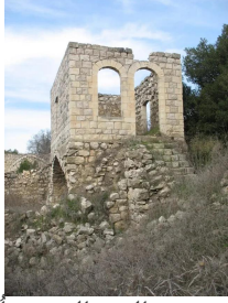
كفر برعم: انقاض احدى بيوت القرية المدمرة، أنقر الصورة لتكبيرها.
