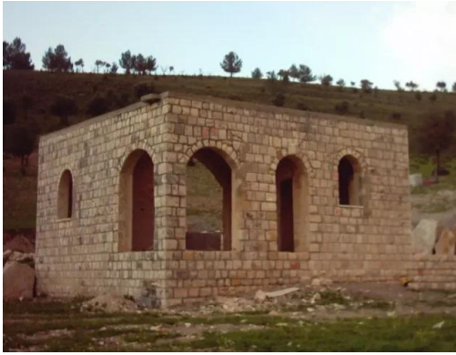
عين الزيتون: مبنى من البيوت المتبقية في عين الزيتون , يقوم اليهود حالياً بترميمه لهدف ما!!..
