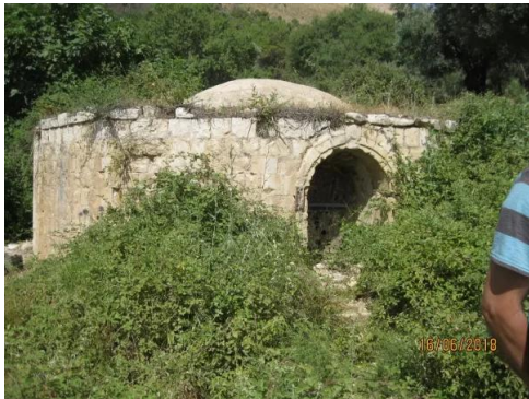
الجاعونة: عين القبة لبب بناء مبني حولها لسقفه قبة
