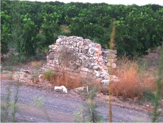
دير طريف: أنقاض لمبنى مهدوم
