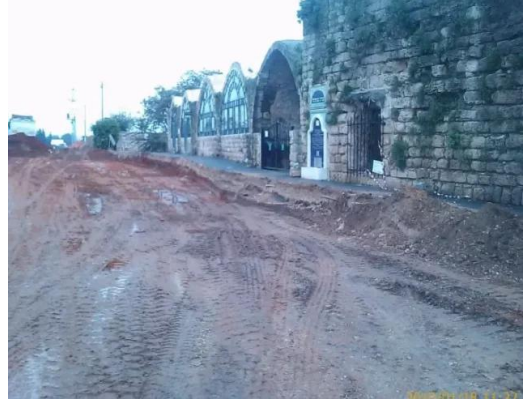
خربة البرج: مسجد خربه البرج
