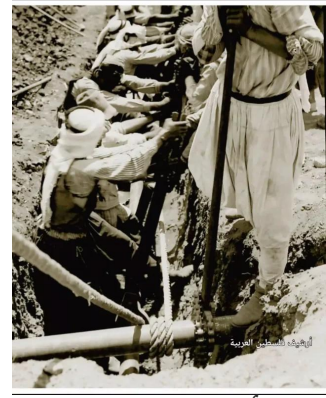
البيرة: تركيب أنابيب شركة نفط العراق للخط الواصل من الموصل نحو حيفا.. التقطت هذه الصورة جنوب البيرة عام 1934 ..
