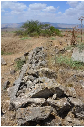
كفرة: أنقاض البيوت المدمرة
