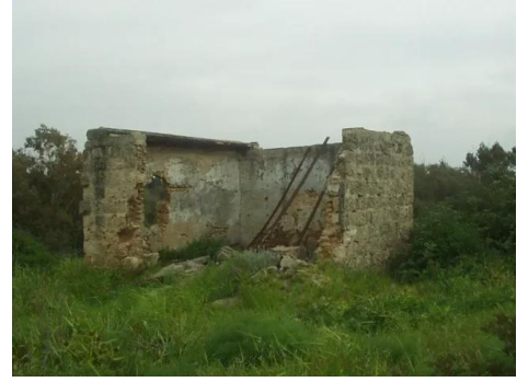
خربة الزبادة: مبنى محرك بئر الماء
