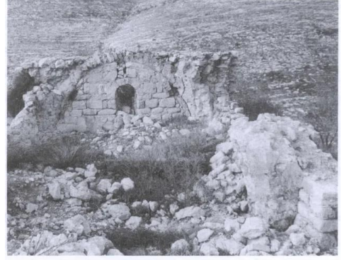
أفقاض وحطام أحد المنازل في موقع القرية (سنة ١٩٨٦) [نطاف] نطاف: أطلال لإحدى البيوت المدمرة. 1986
