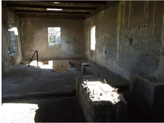
جولس: بئر عميق وفوقه مبنى كبير
